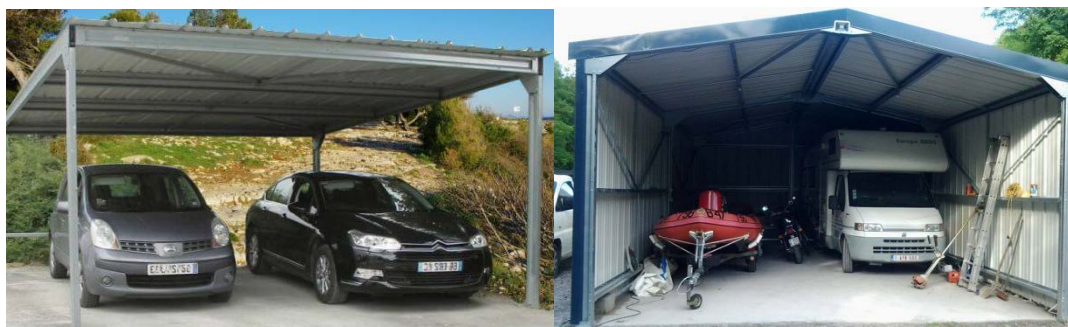
Εικ. 3: Μεταλλικά στέγαστρα αυτοκινήτων
