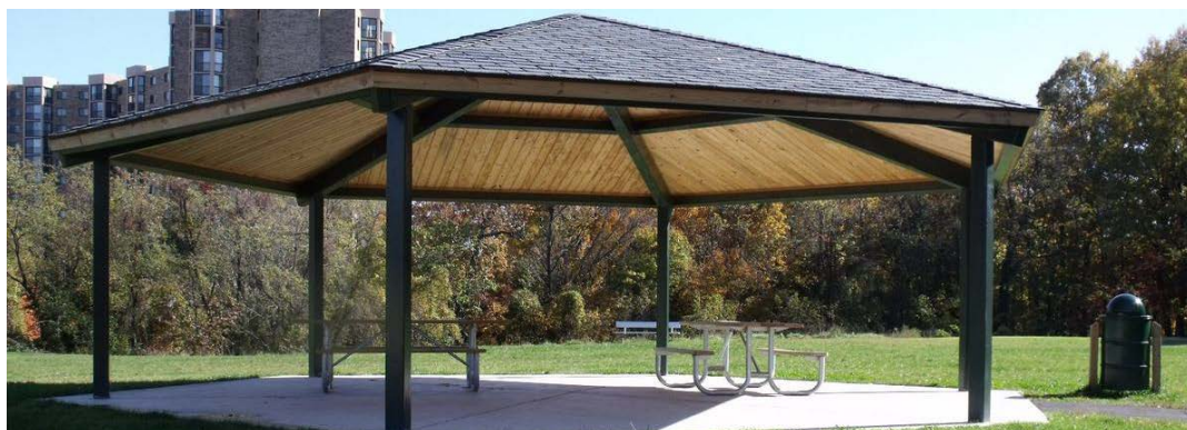
Εικ. 2: Στέγαστρο από ξύλο και μεταλλικό σκελετό
